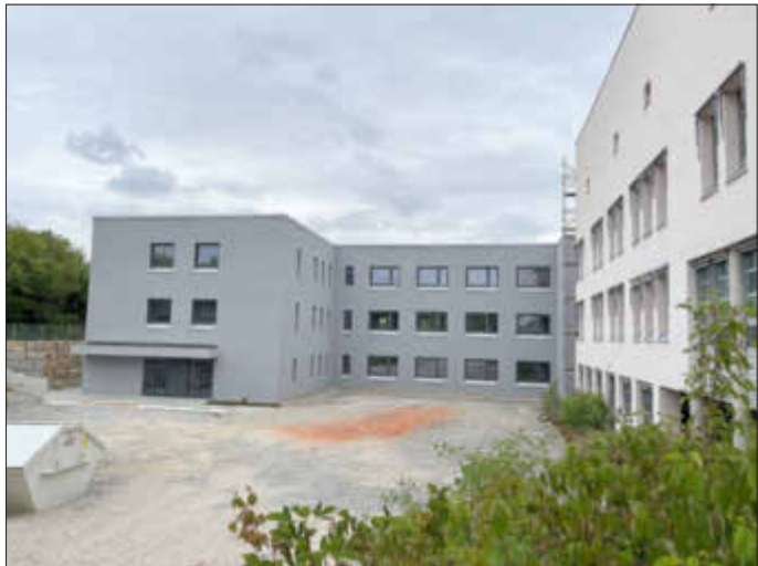
Der Bauteil D des Landratsamts steht für den Bezug bereit. Ab 1. September 2025 werden die Mitarbeitenden die neuen Räumlichkeiten beziehen.
