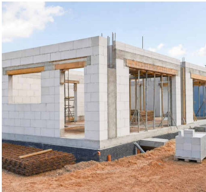
Rohbau eines Massivhauses mit gemauerten Außenwänden, Betondecke und vorbereiteten Fensteröffnungen.
